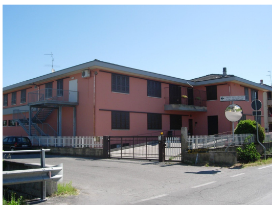
Centro Diurno Disabili e sede
